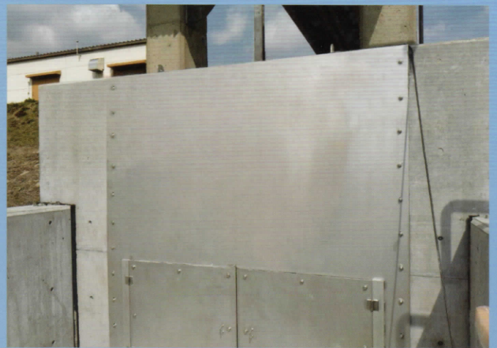
プレートガーダ構造ステンレス鋼製止水壁
