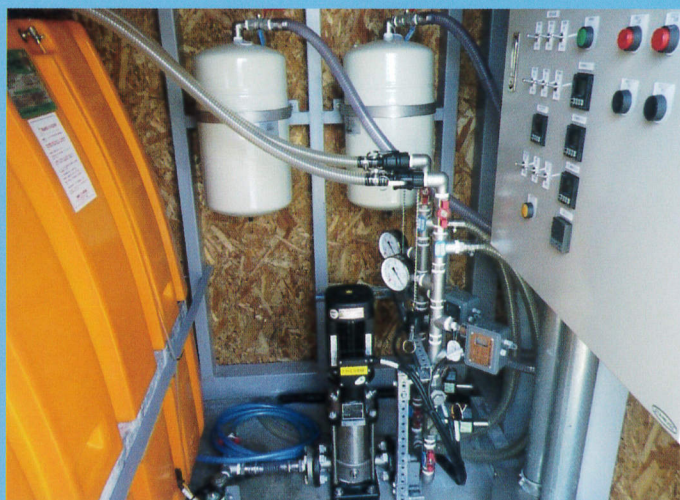
格納小屋内部
