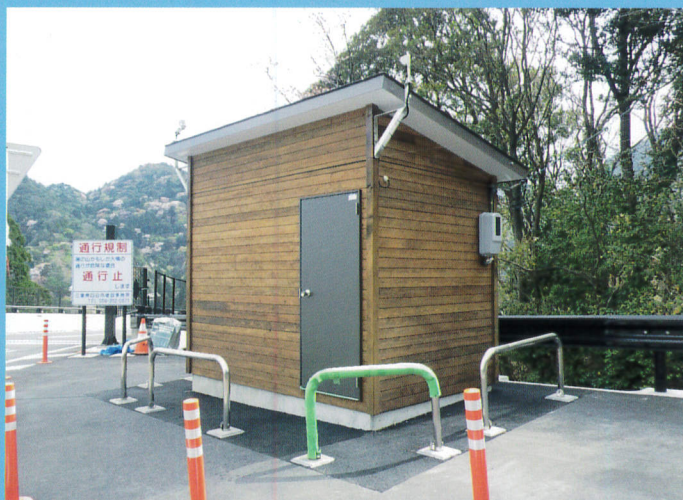
凍結防止剤供給装置格納小屋
