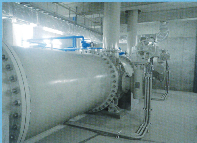
φ1500mm 吐出合流管、バタフライ弁
