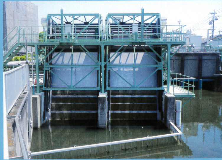
間欠式自動除塵機回転アーム形 水路幅 4,000\text{mm} \times 高さ 2,450\text{mm}
