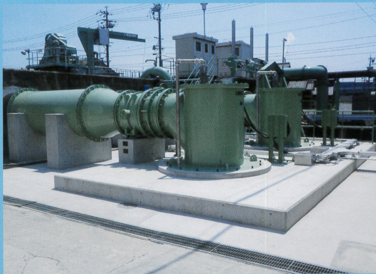
コラム式水中斜流ポンプ 口径 \phi 1,000\text{mm} 吐出量 200\text{m}^3/\text{min} \times 4.0\text{m}
