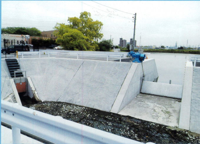
野田調整池(1号箇所) 全体
