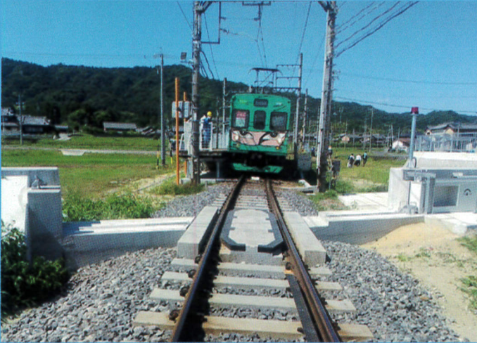
伊賀鉄道第1陸閘 横引ゲート格納状態
