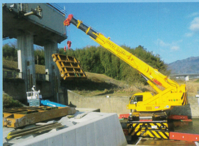
扉体据付状況
