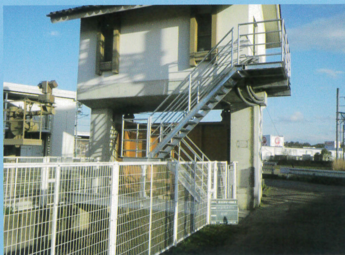
階段製作設置
