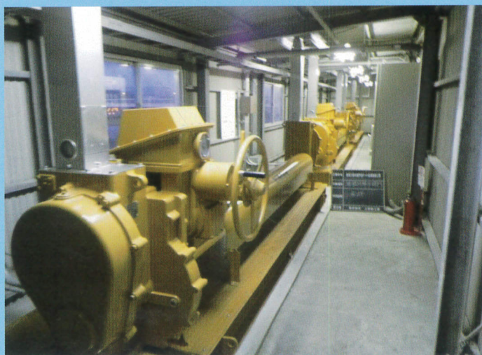
開閉装置取替
