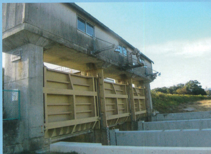
扉体塗り替え
