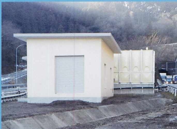
中在家ポンプ室
