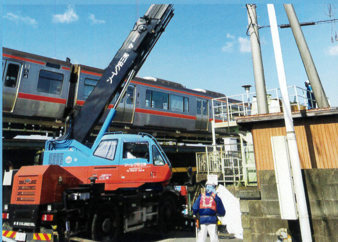
鉄道隣接作業状況
