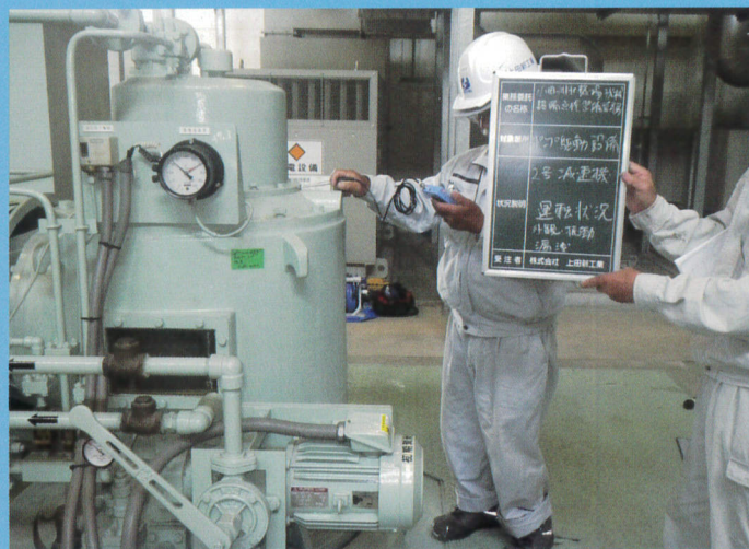
小田排水機場 振動測定
