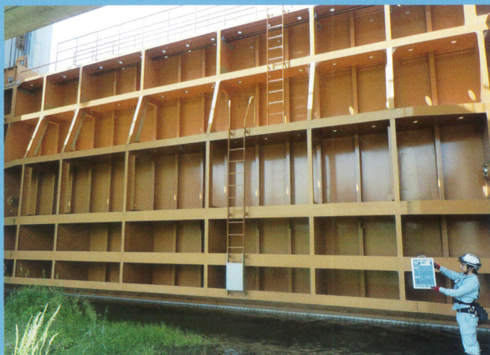
木津川上流 全閉 水密確認
