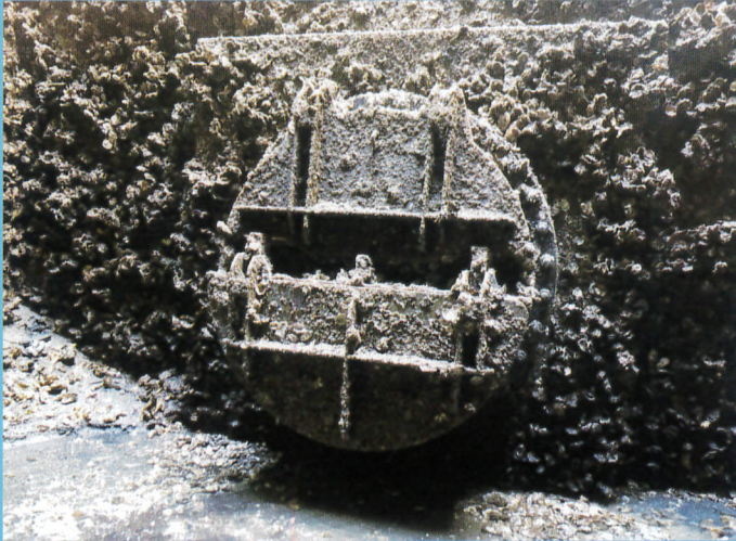
No.1雨水ポンプ用逆流防止弁(着手前)
