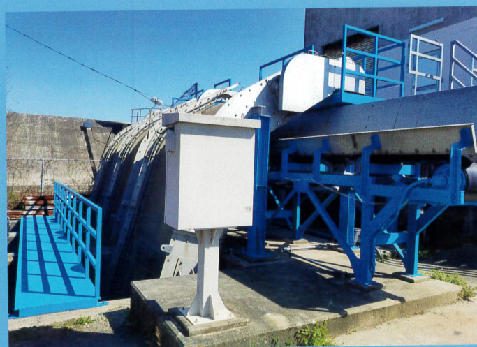
【補修】除塵機／コンベア塗替塗装
