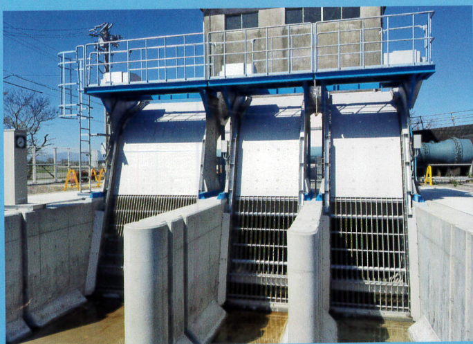
【新設】No.1～3除塵機前面
