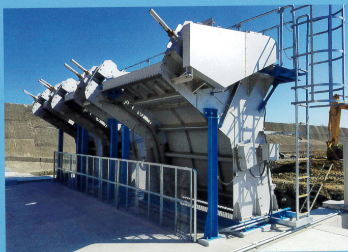
【新設】No.1～3除塵機背面
